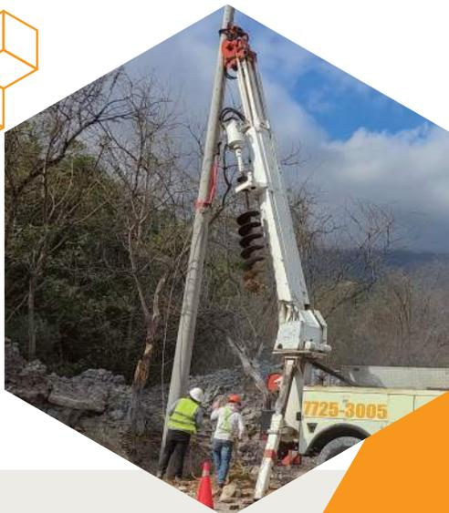
**Instalaciones de postes de concreto y de madera con su tendido eléctrico**
