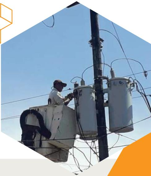
**Desmontaje de transformadores desde 10 KVA hasta 100KVA.**
